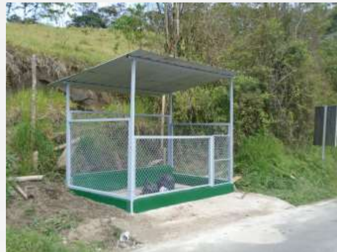
SECTOR GUALEA CENTRO SUB CENTRO DE SALUD
